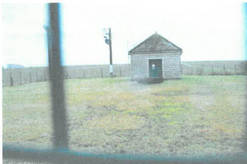
Le forage se situe devant la chambre de captage
